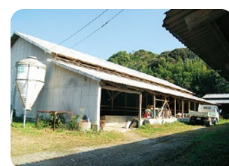
▲敷地内には、掃除の行き届いた牛舎が3棟。
